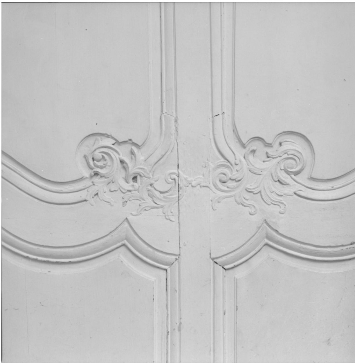
Détail des lambris du cabinet.
