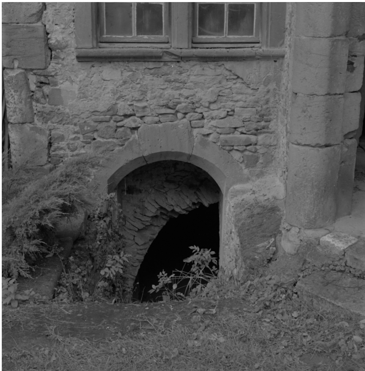
Détail de l'élévation nord-ouest : fenêtre de la salle du logis B et pierre d'écoulement.
