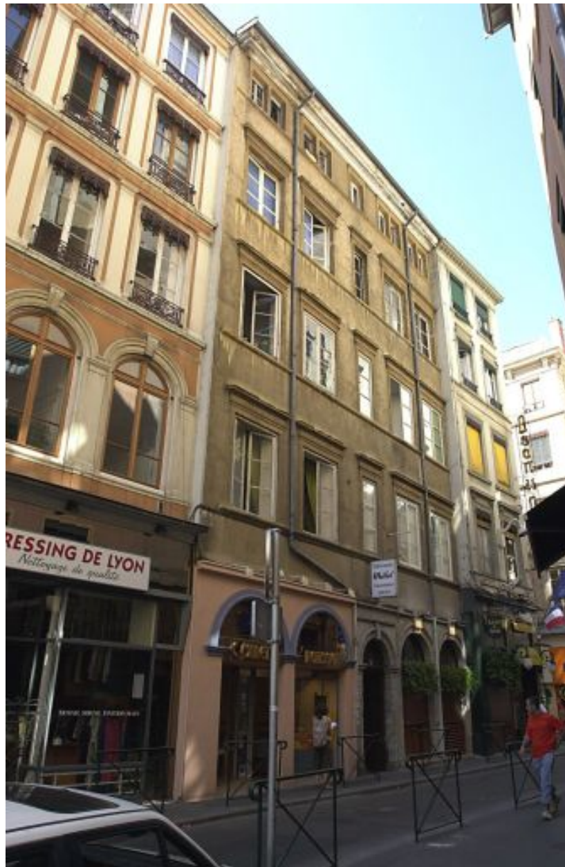
Façade principale sur rue, vue générale
