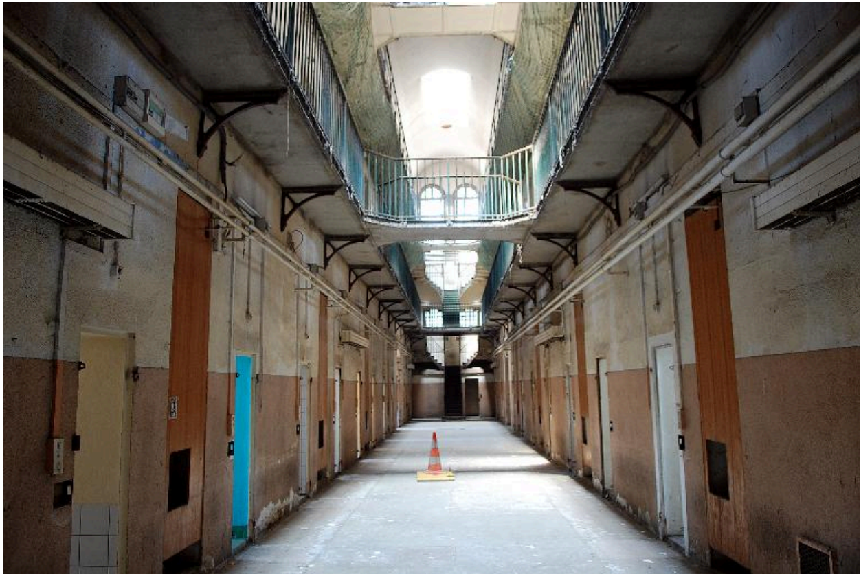
Etat en 2010 : l'aile nord depuis le rez-de-chaussée
