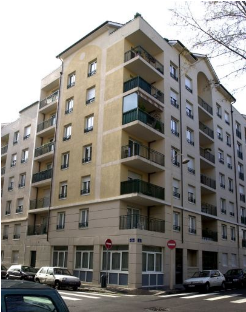
Vue d'ensemble à l'angle de la rue Smith et de la rue Marc-Antoine-Petit depuis le nord-est
