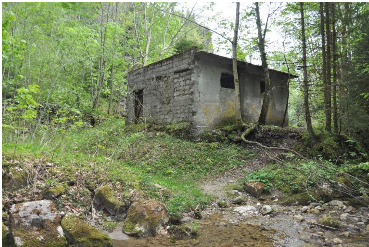
Vue générale de la remise de la mine d'Entrevernes
