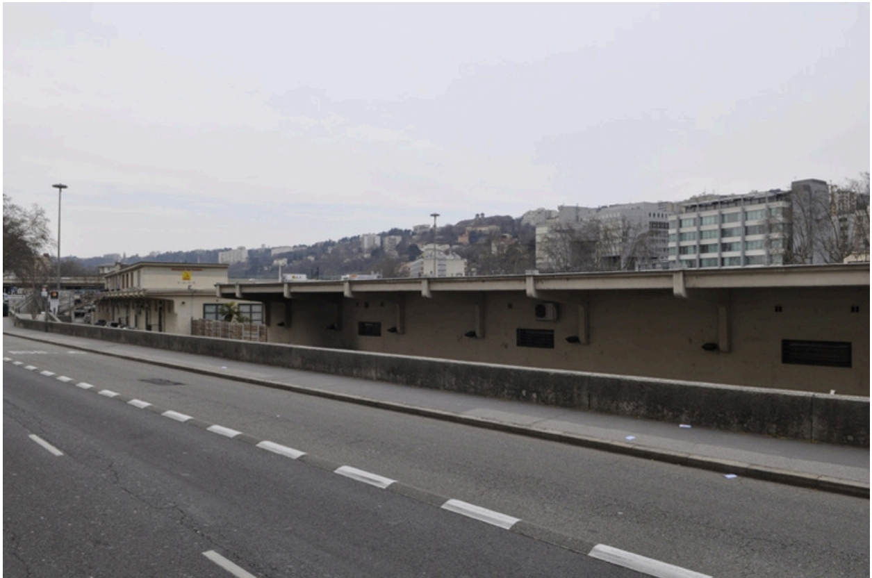
Vue d'ensemble nord du site
