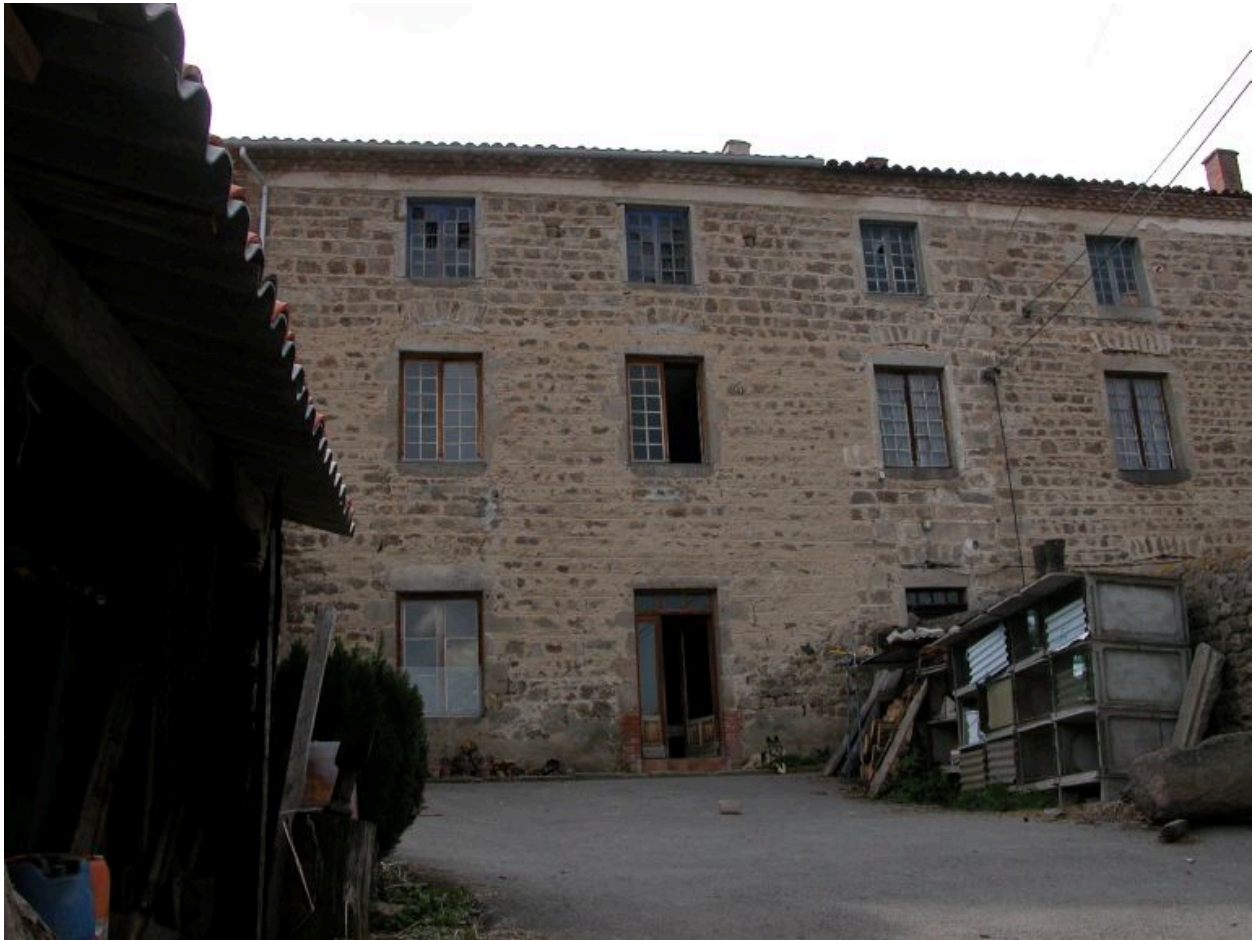
Vue partielle du logis, côté gauche. Parcelles 261 et 260.
