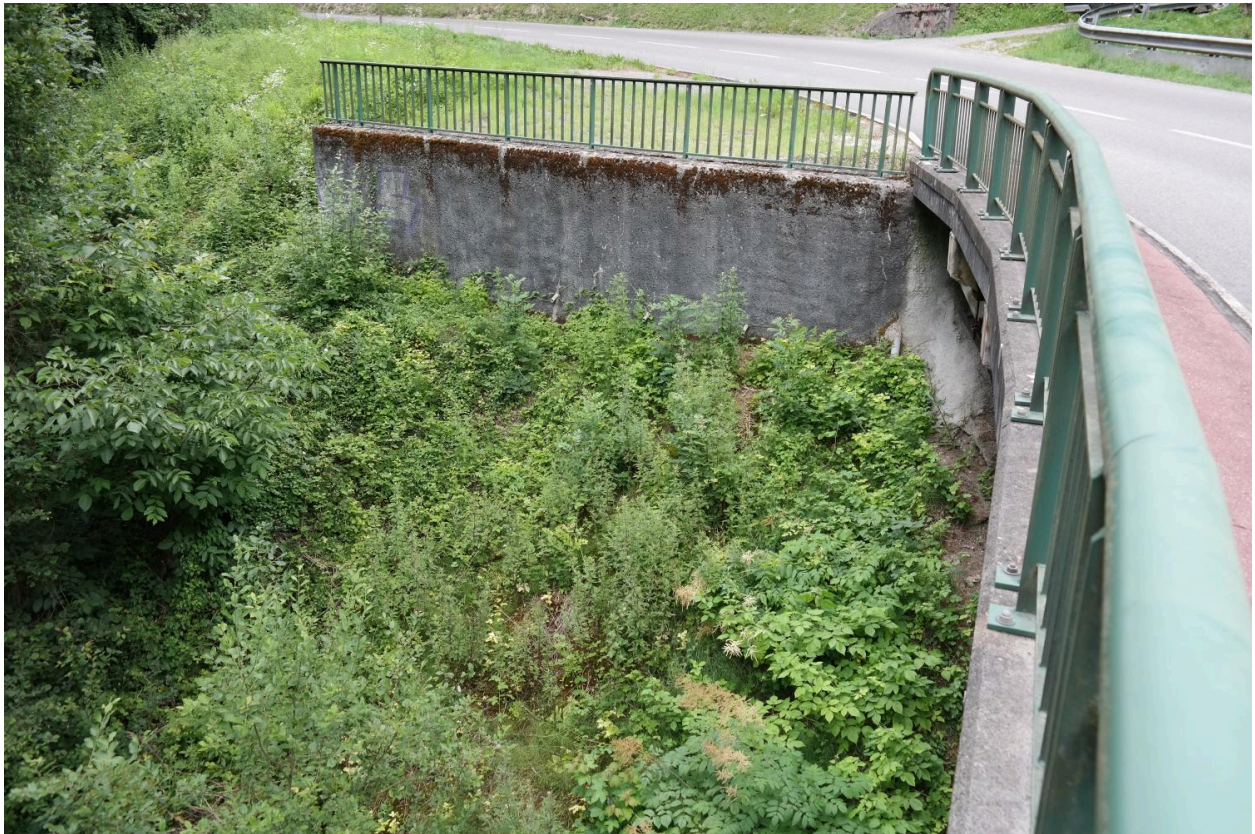
Pont de Vaulx, détail de la réfécion du talus
