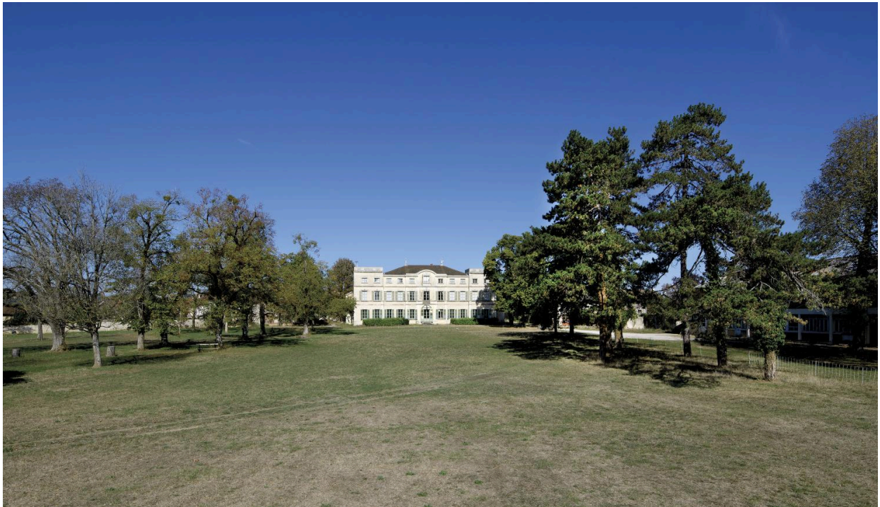
Vue du château, depuis le parc
