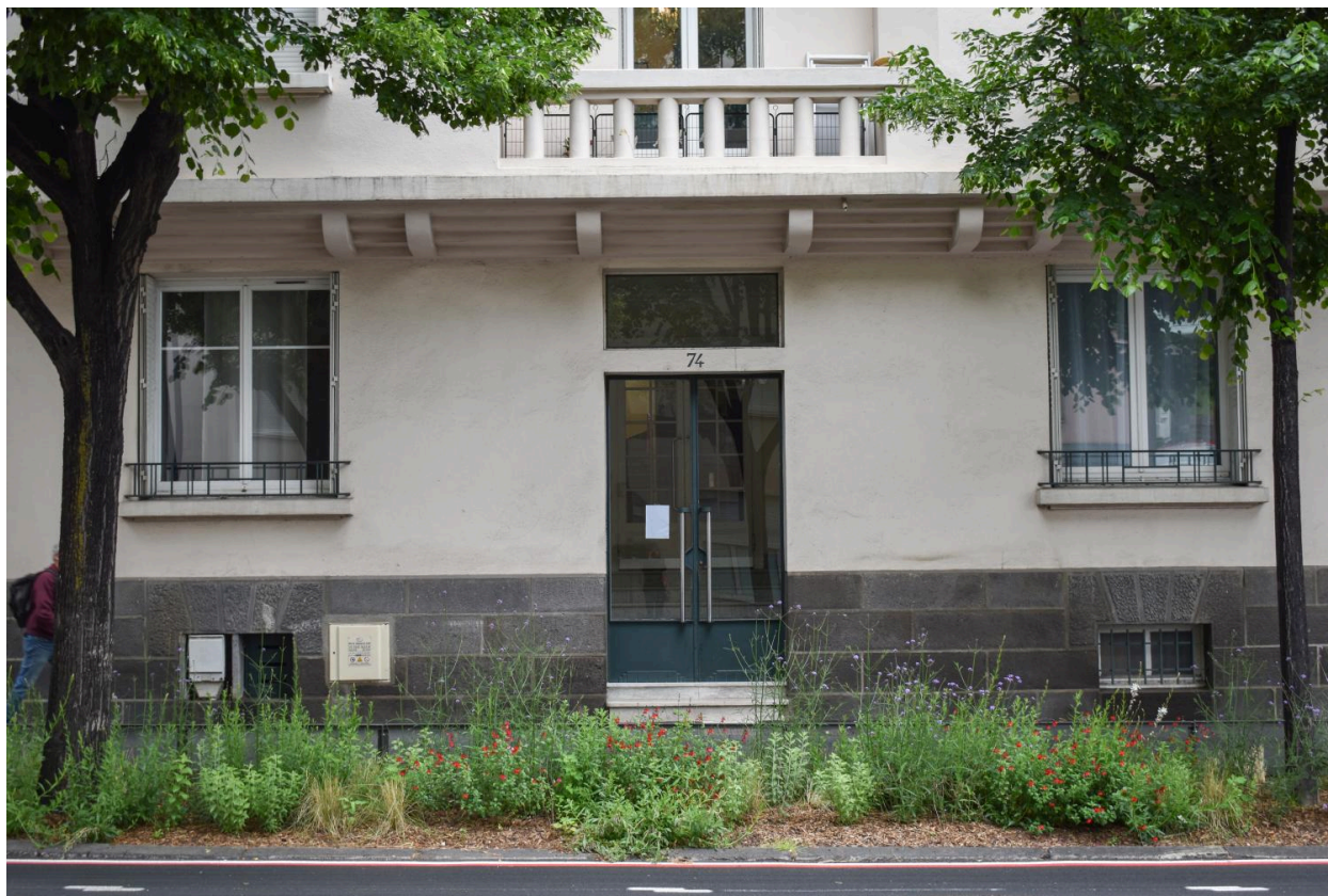
Porte d'entrée sur le boulevard
