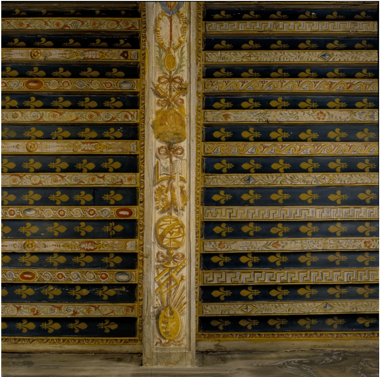
Poutre 2, face inférieure, côté gauche : les Arts plastiques et les Arts libéraux, distinctions honorifiques.
