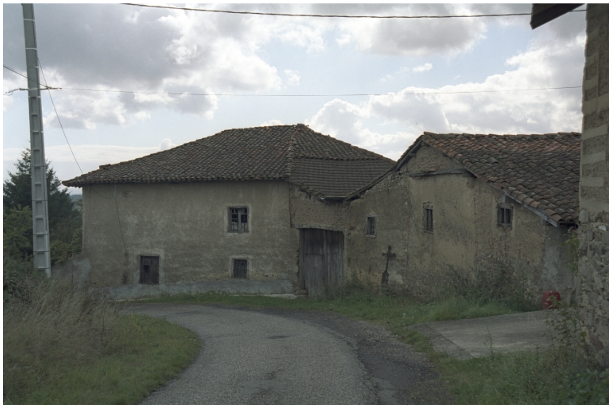
Vue générale extérieure depuis le nord.
