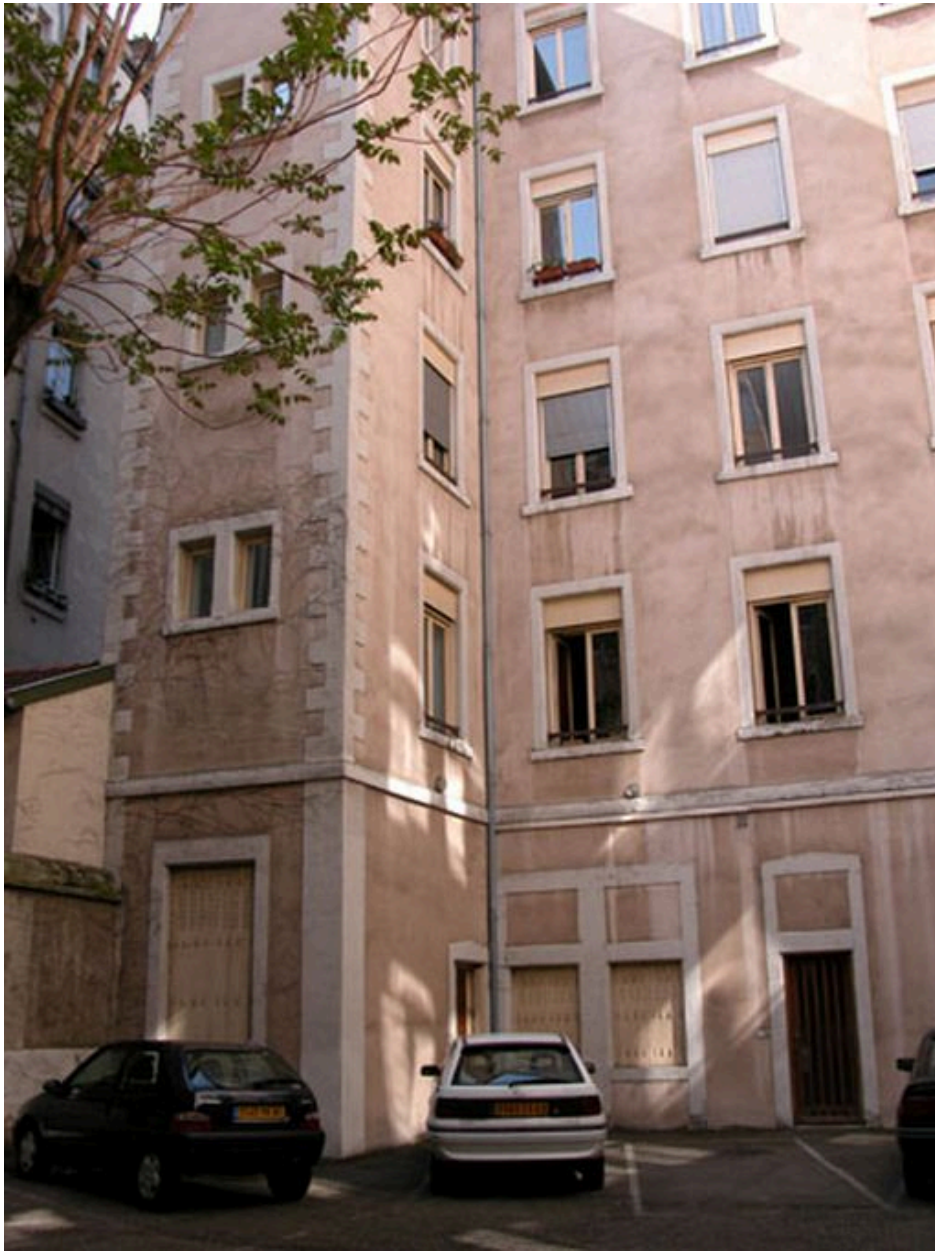
Elévation postérieure, angle sud-est
