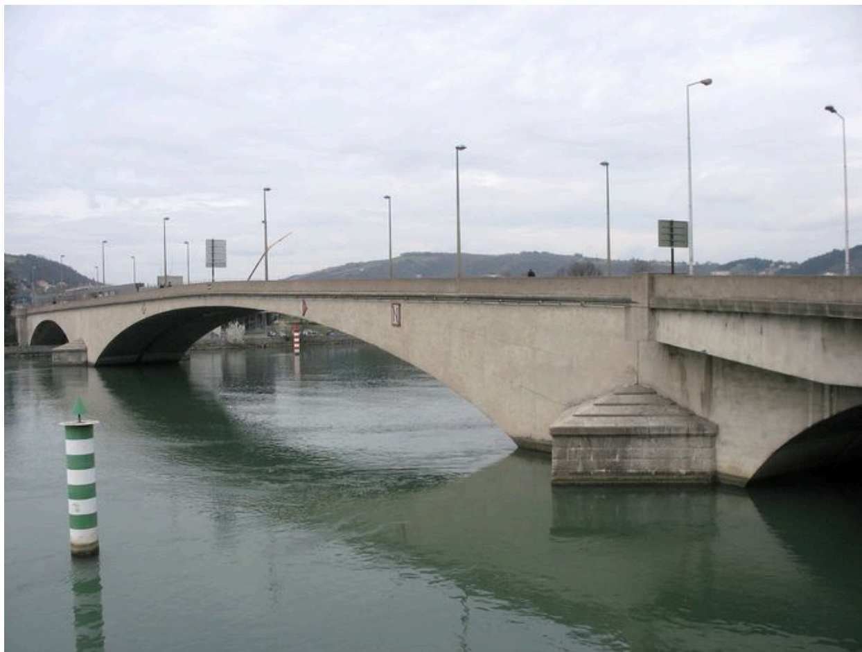
Vue du pont, côté aval (depuis la rive gauche)
