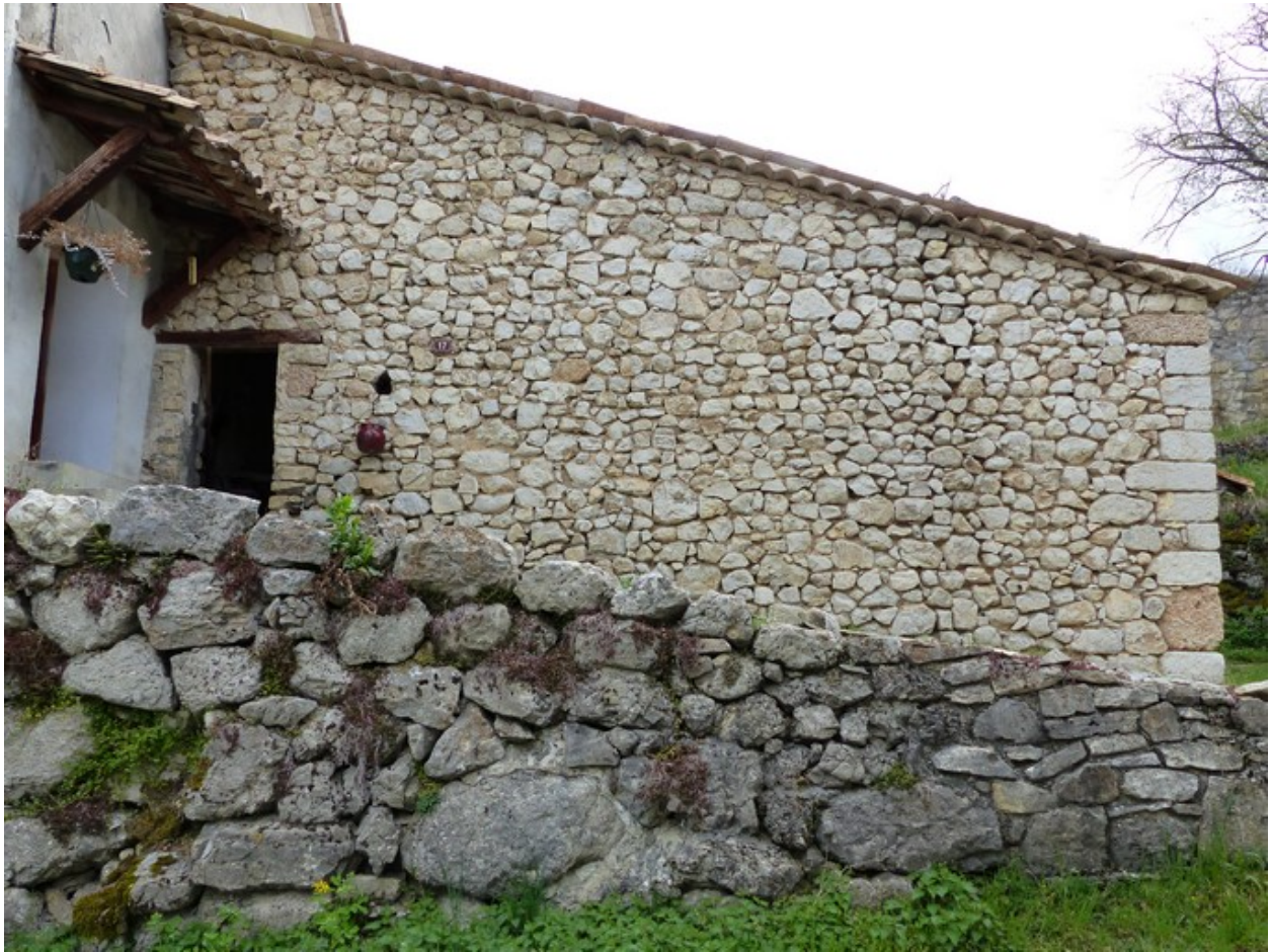
Bâtiment de la remise. Pignon ouest.
