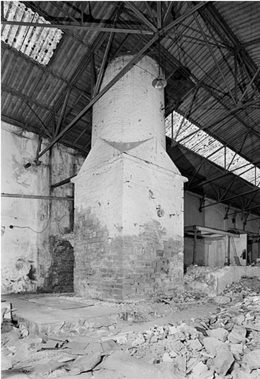
Base de la cheminée située à l'intérieure de l'atelier
