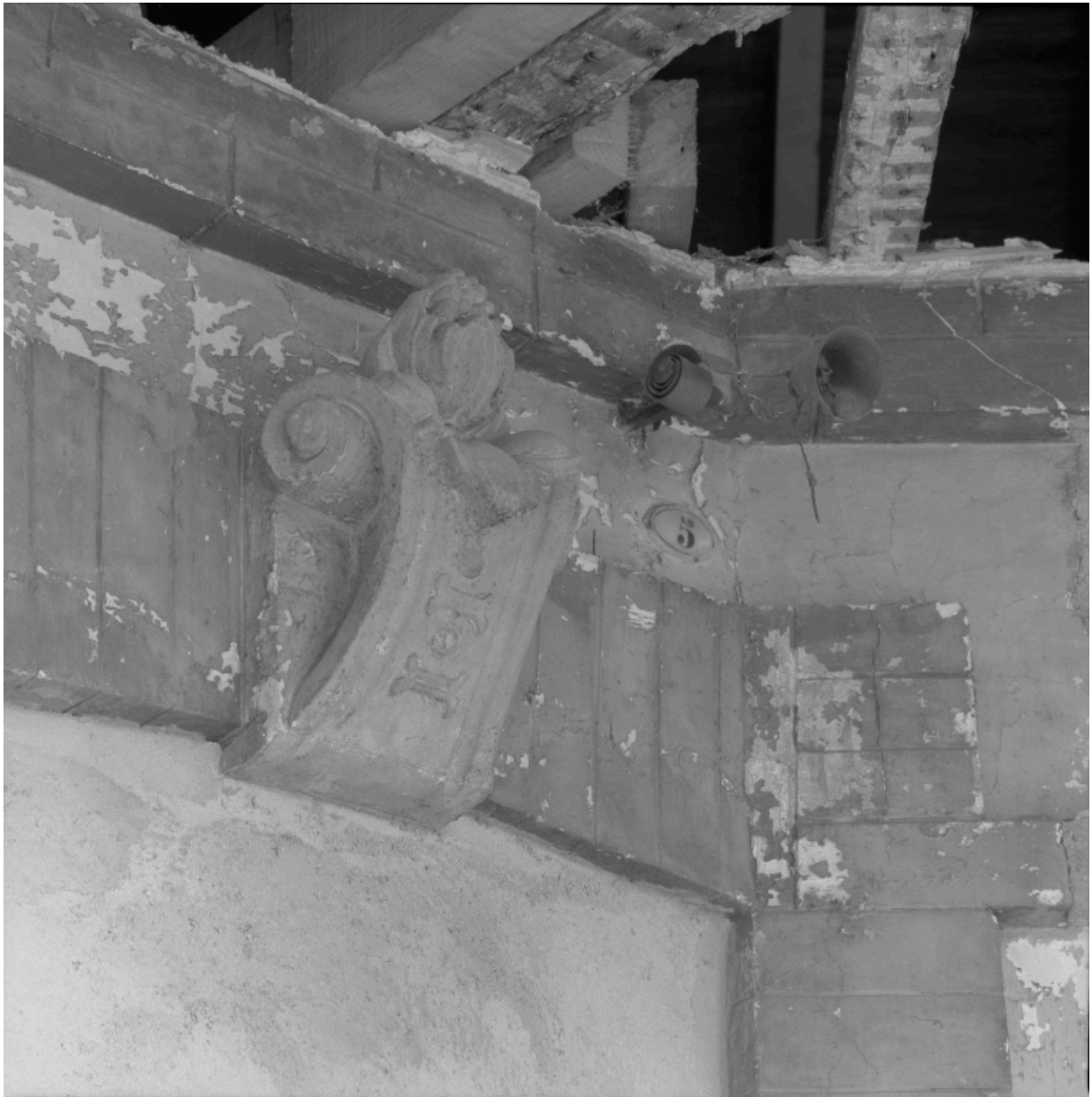
Aile gauche des bains - douches, détail d'une clef d'arc d'une des cabines, avec clochettes d'appel et numéro de cabine.
