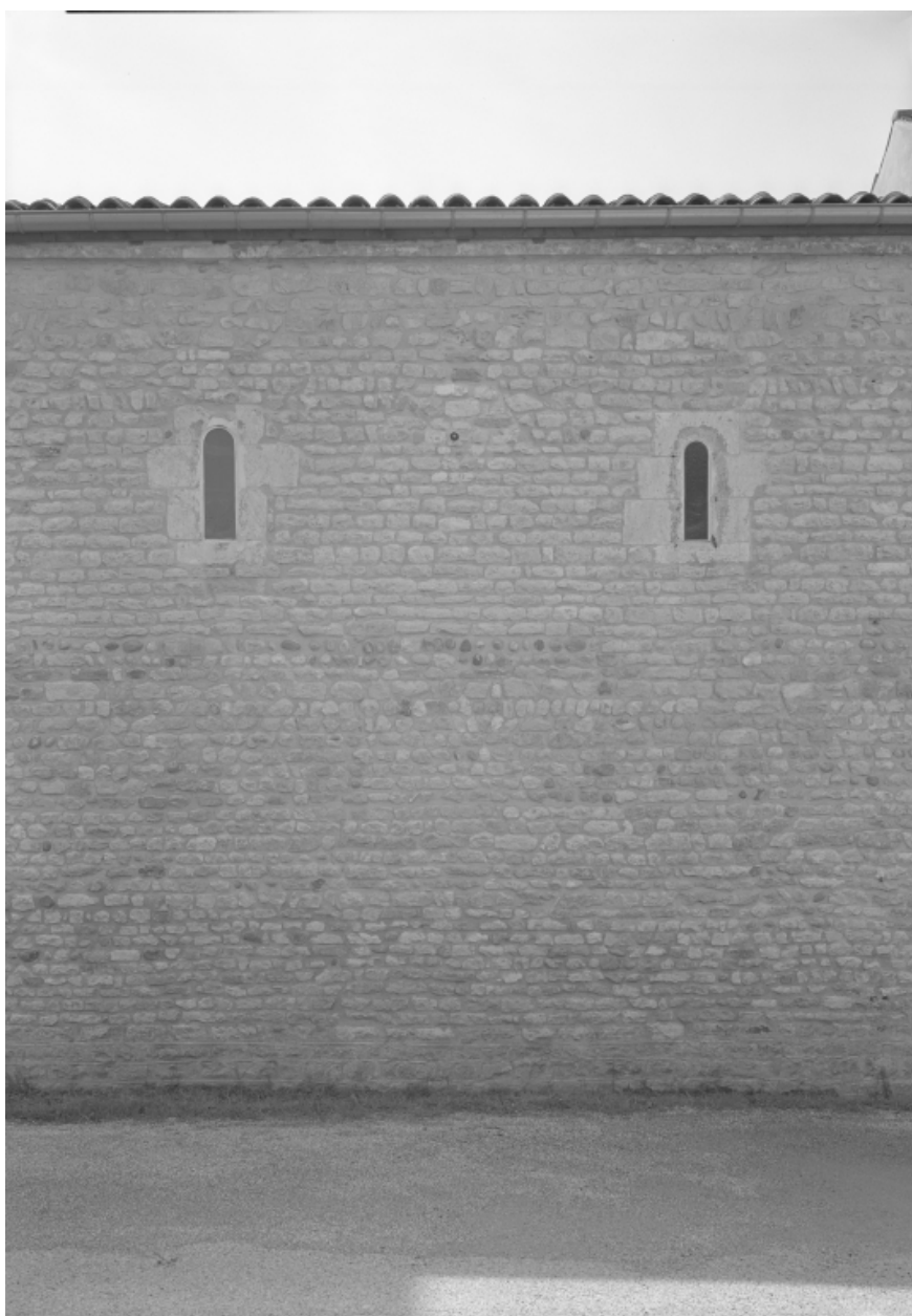
Elévation nord, détail.
