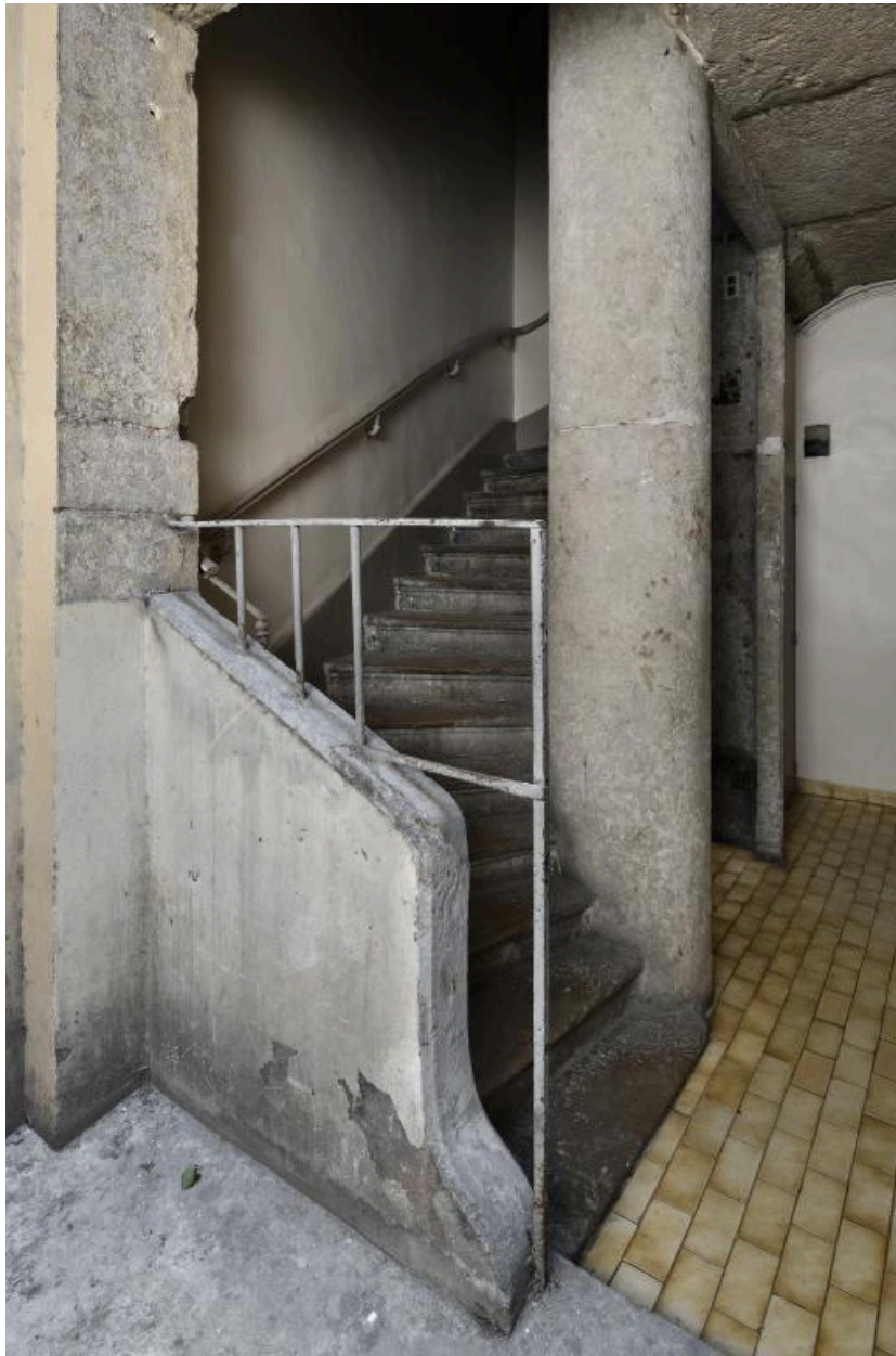
Le départ d'escalier depuis la cour
