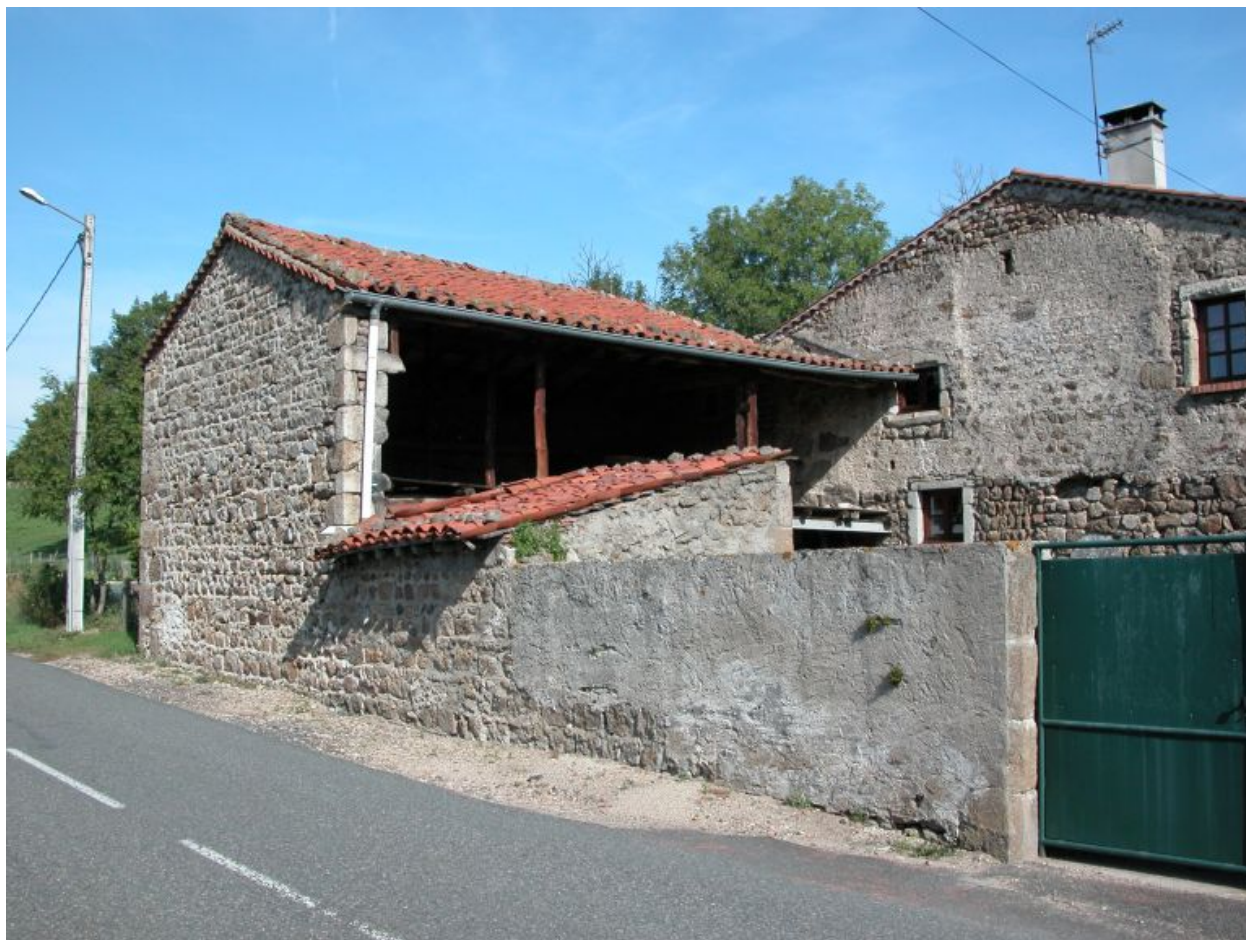
Vue d'ensemble du hangar depuis la rue.
