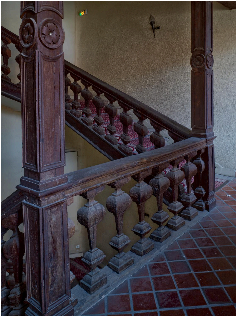
Aile est : escalier, détail
