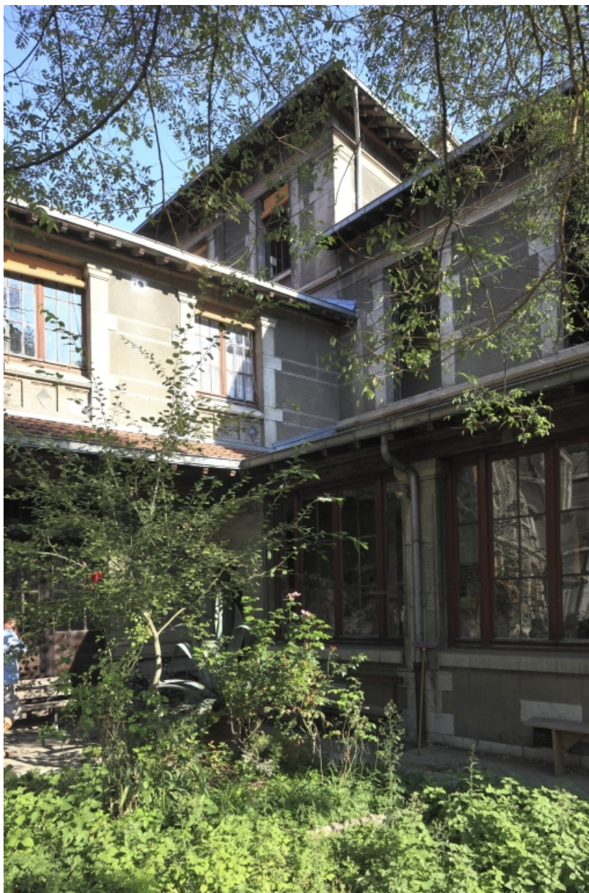
Cour F. Dite de l'infirmerie. Vue partielle, depuis le sud-ouest (détail de l'angle)
