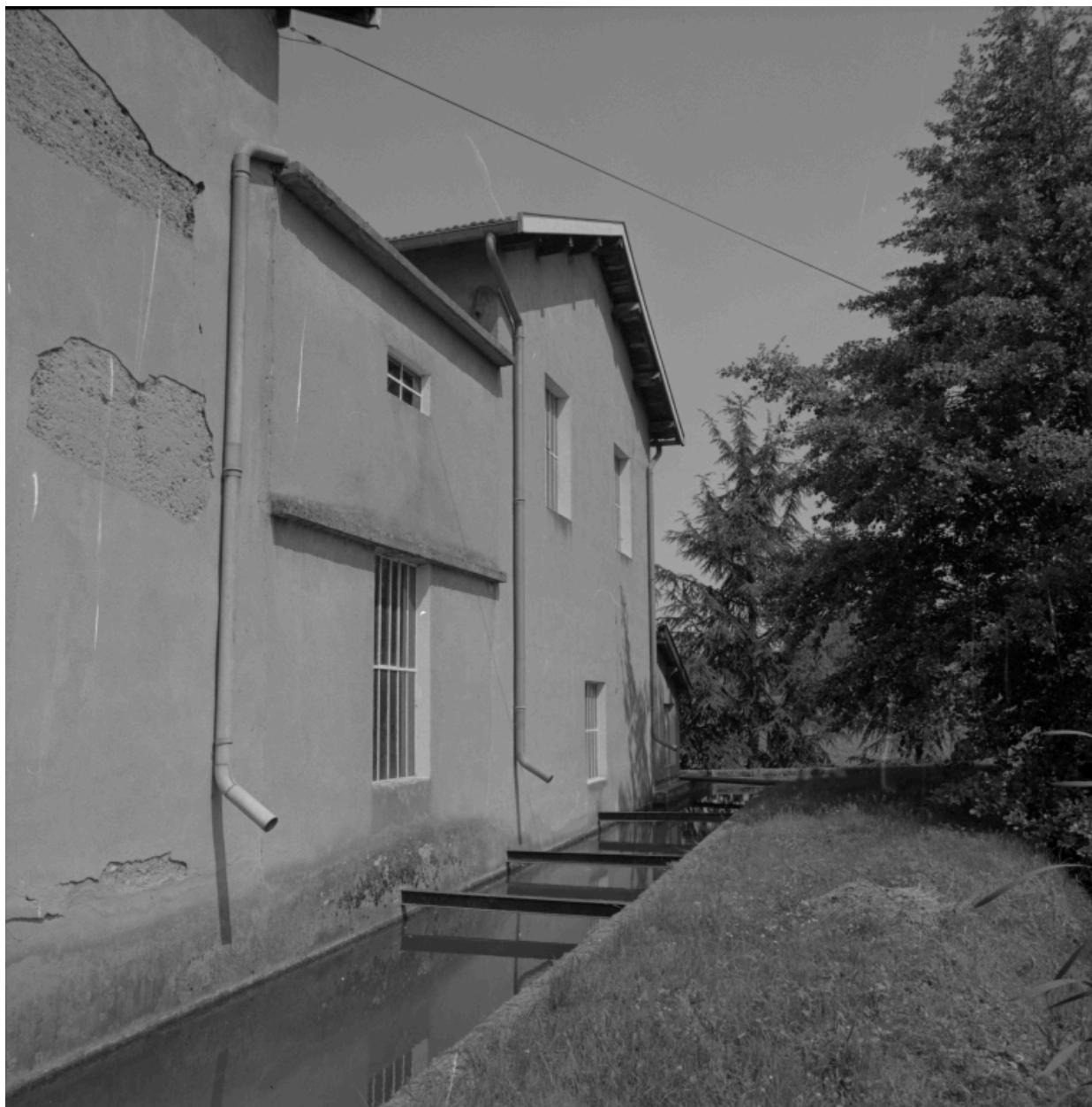
Partie du bief longeant le moulin, vue depuis le sud.
