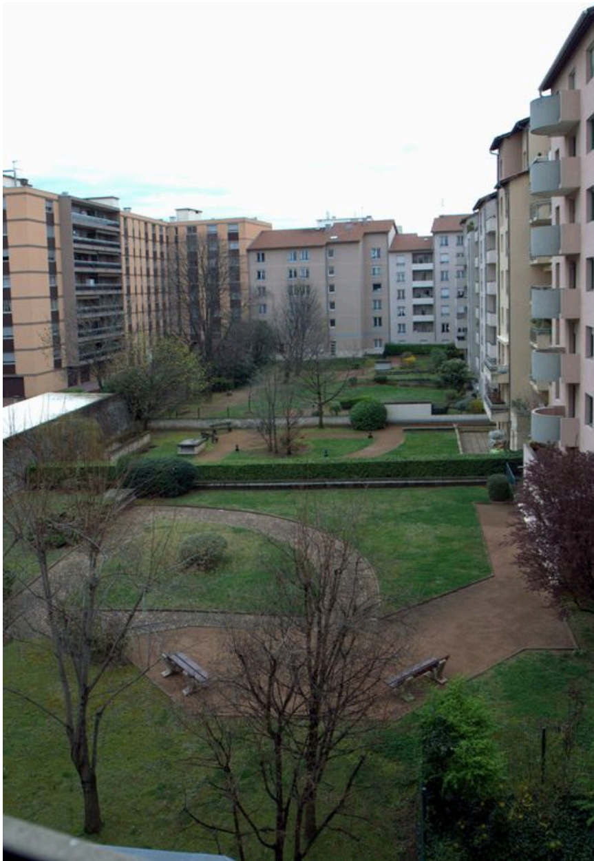
Elévations postérieures et coeur d'îlot, depuis le nord
