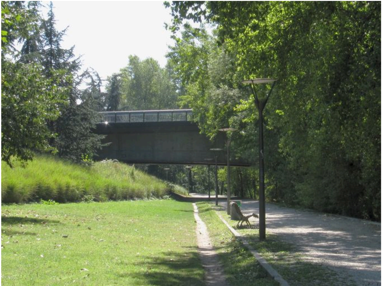
Travée de rive gauche, face amont, vue partielle : voie piétonne en dessous (depuis la rive gauche)
