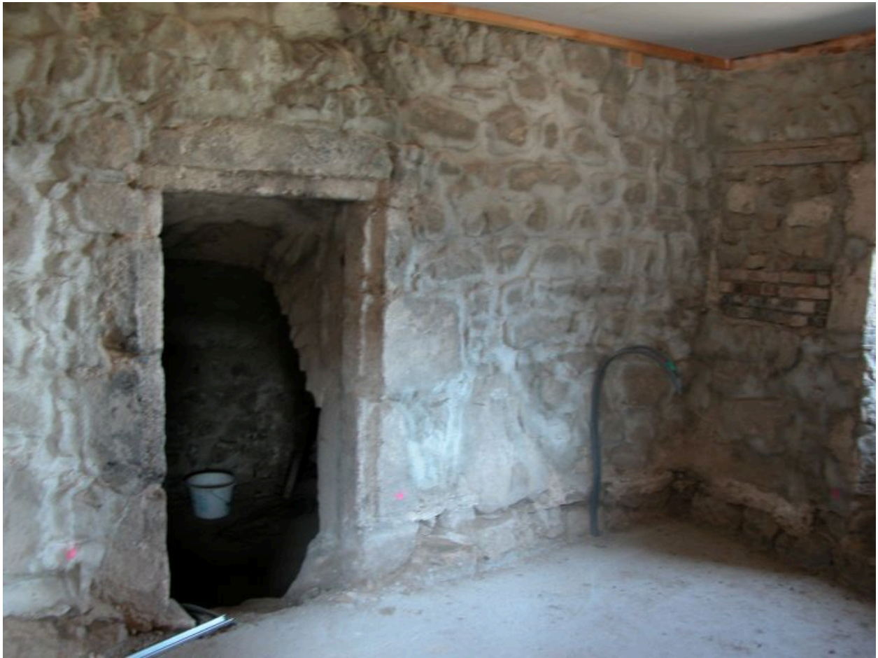
Vue intérieure du rez-de-chaussée du logis 4 : entrée de la cave (état en 2011).
