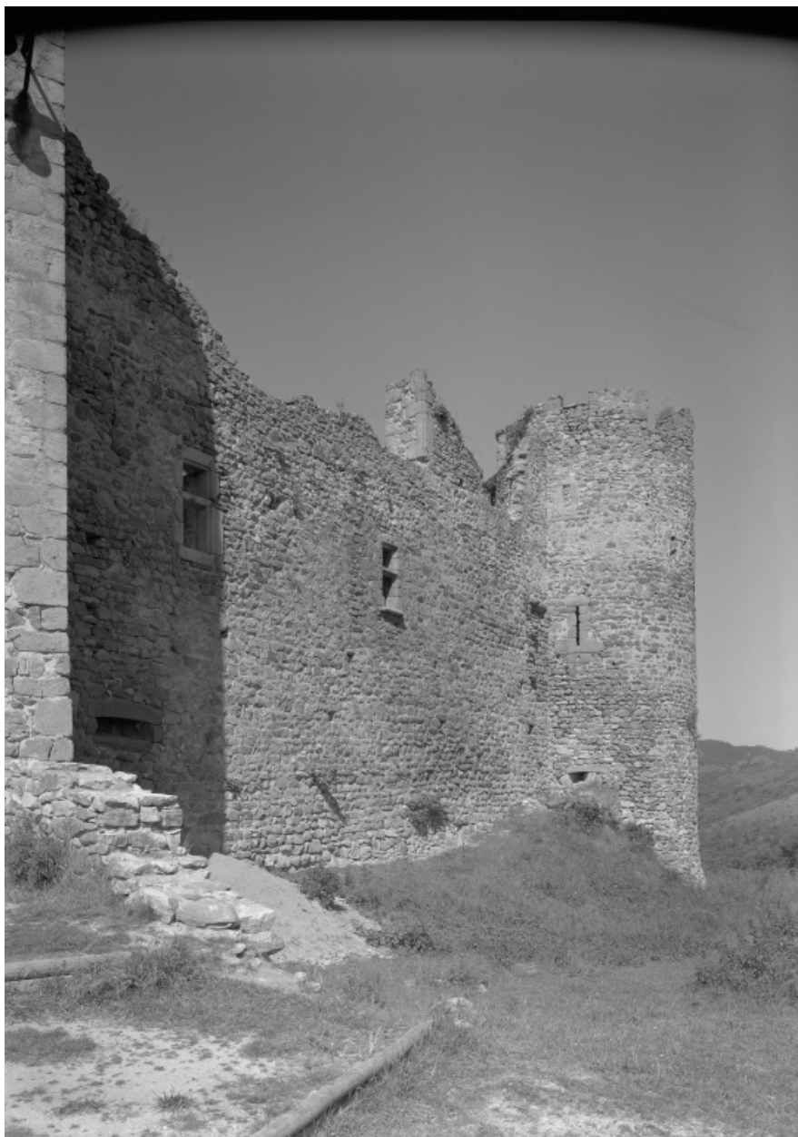
Vue extérieure de la partie nord-est de la première enceinte, de l'est.
