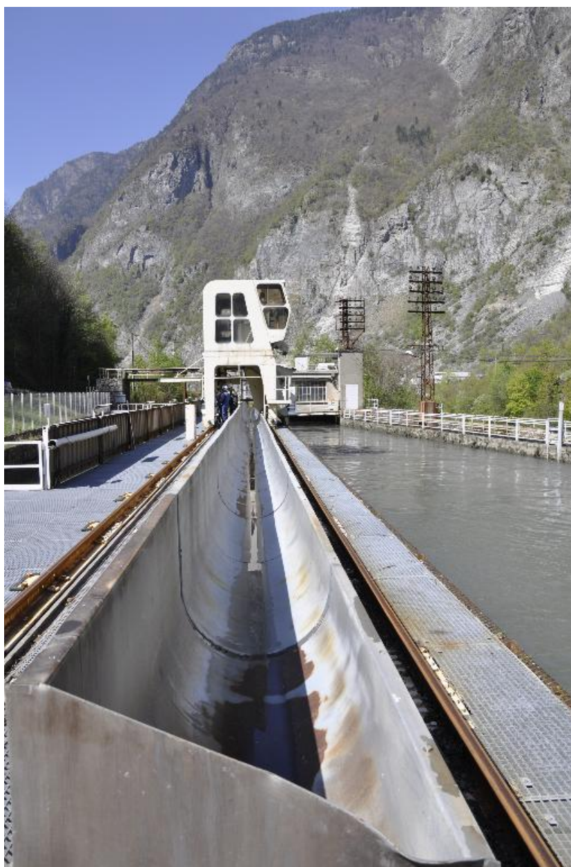
Vue du dégrilleur du barrage
