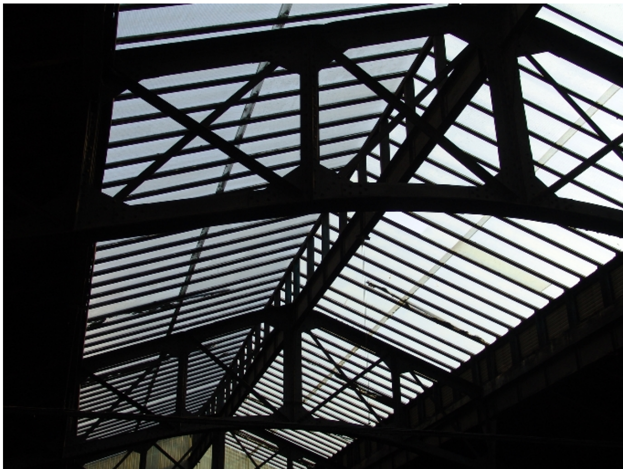
Verrière zénithale de la grande halle
