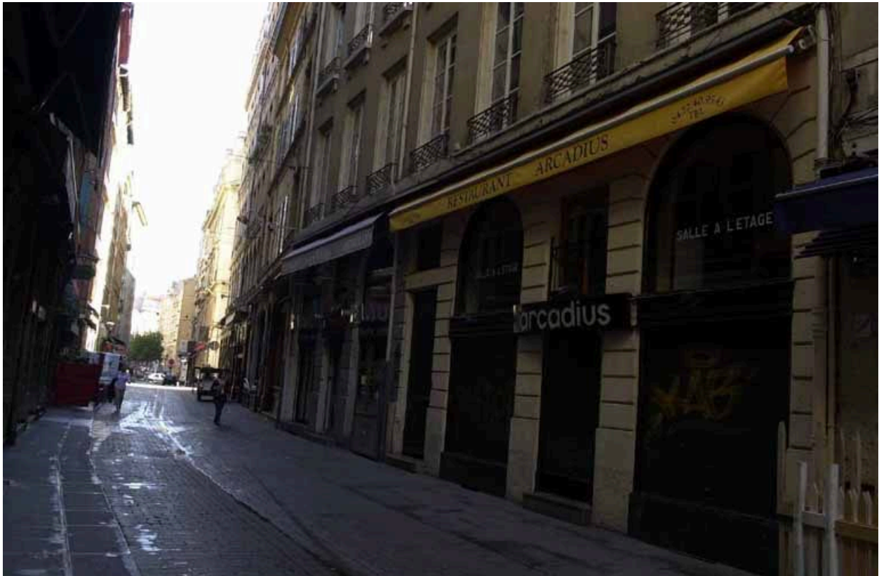
Rue Mercière : le rez-de-chaussée
