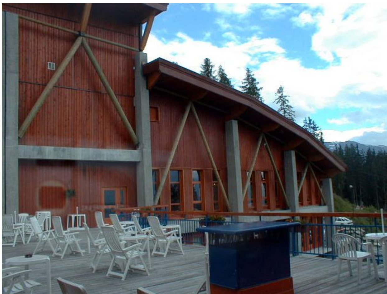
Façade sud-est, partie droite : coursive desservant les studios
