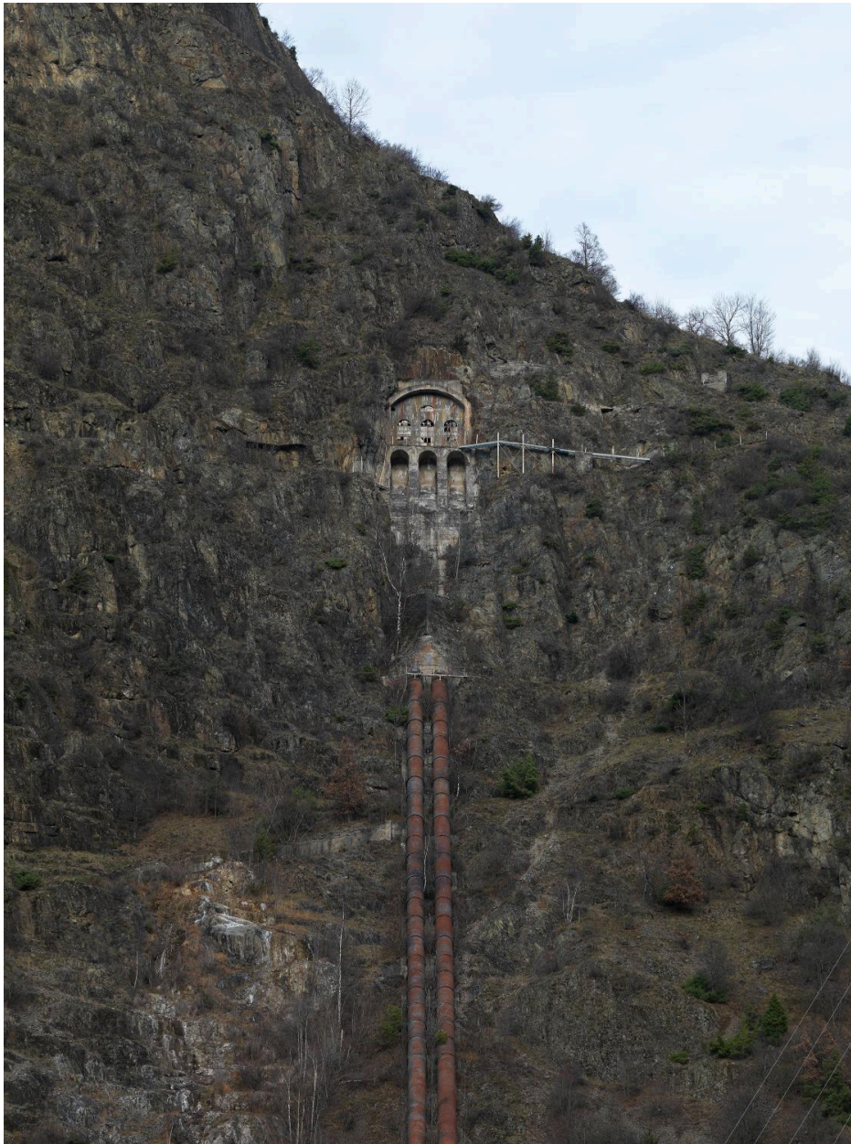
Chambre de mise en charge et conduites forcées de la centrale de Saint-Guillerme I.
