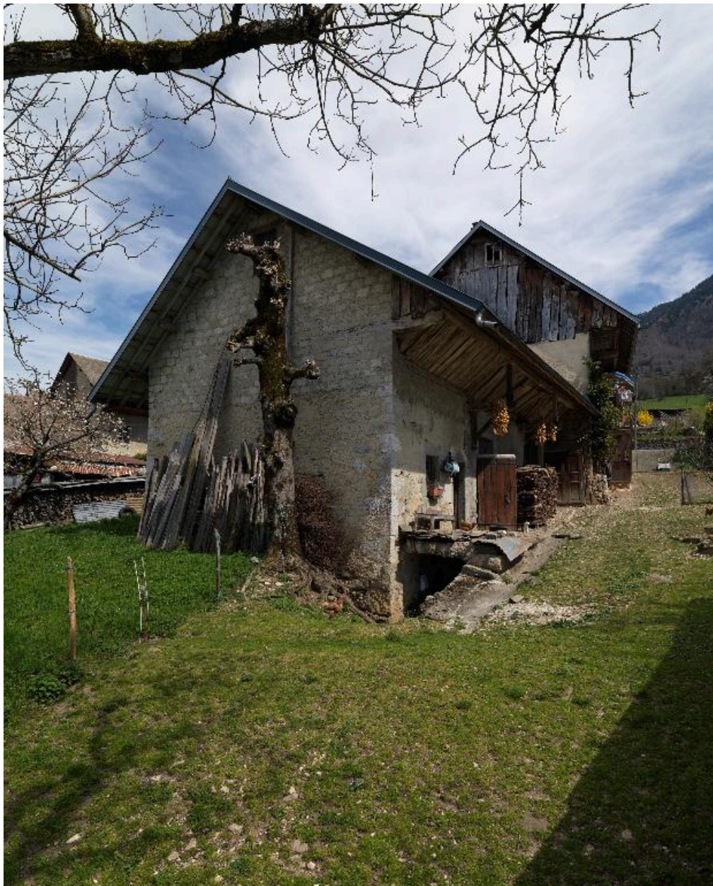
Vue d'ensemble de la ferme de trois-quarts depuis le sud-ouest
