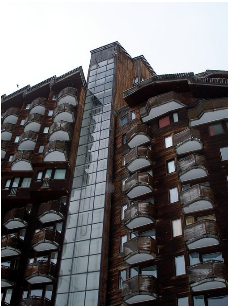
Elévation ouest : l'ascenseur public et les balcons
