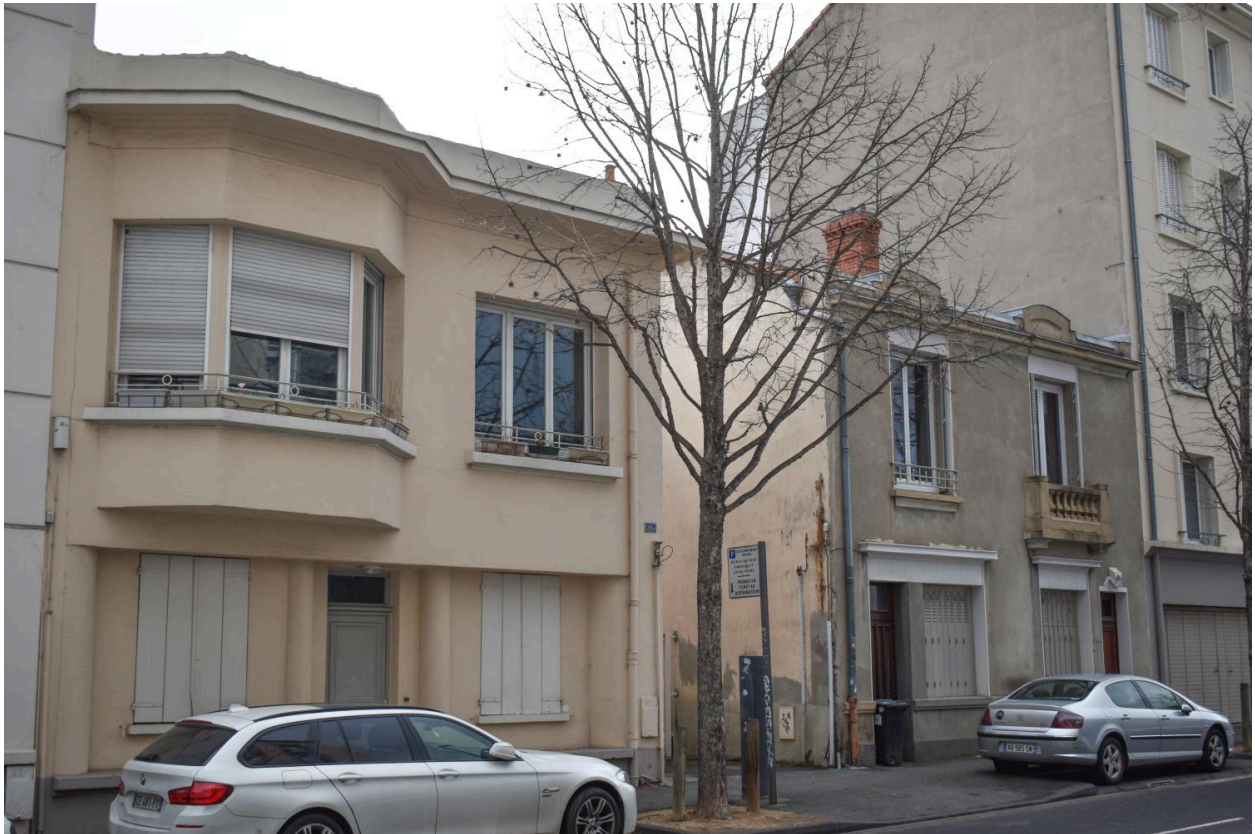
Façades des 17bis et 19 avenue d'Italie
