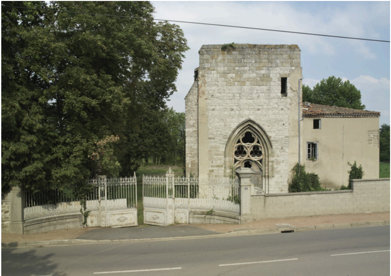
Vue générale de la façade de la chapelle
