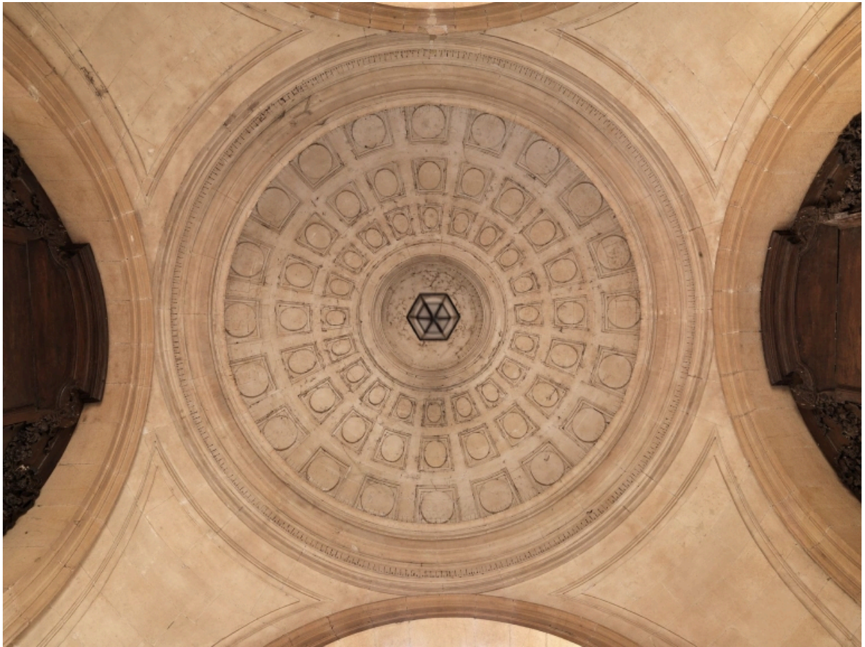
L'entrée principale. La coupole du corps de passage
