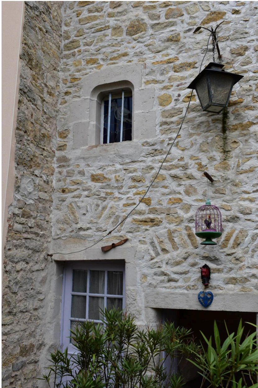
Détail des ouvertures dans le mur gouttereau sud-est.
