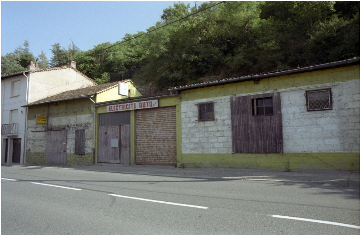
Boën, îlot 20, RN 89,15 et 13. Vue générale de la façade sur rue.
