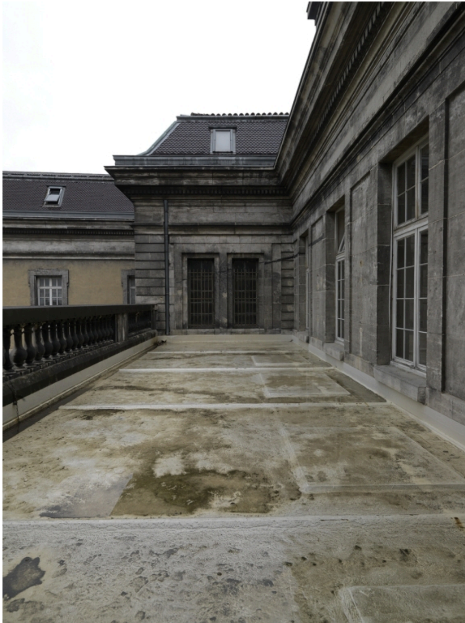
Bâtiment A. La terrasse depuis le sud
