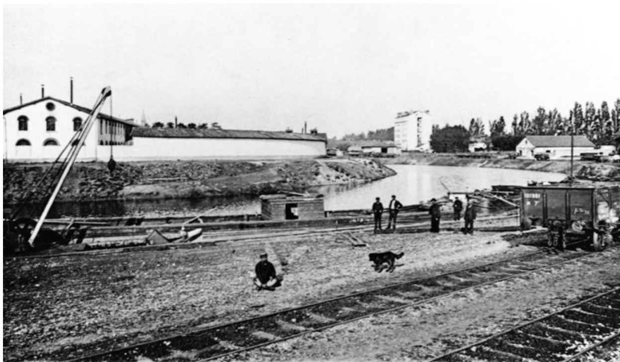
Vue de la gare d'eau, côté est, depuis le sud, vers 1925
