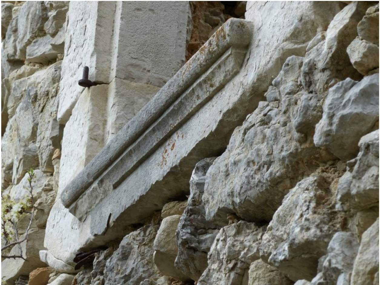
Appui de fenêtre mouluré, ferme au hameau du Génisseau.
