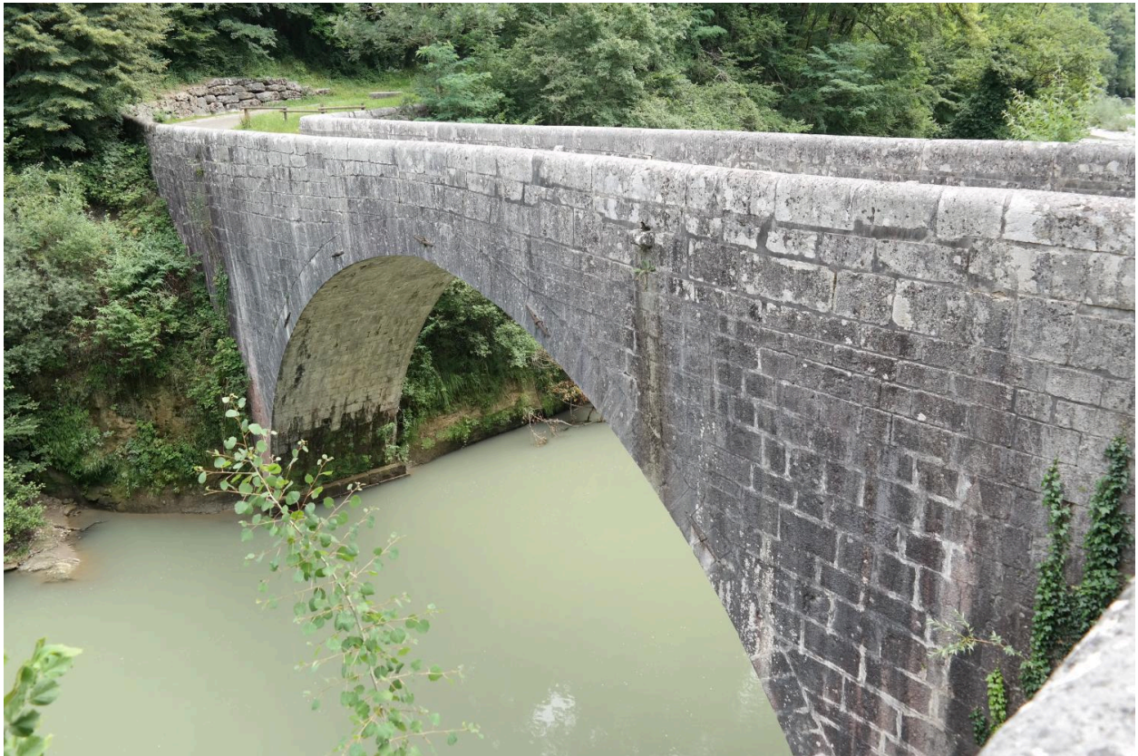
Pont Coppet, vue de la face amont
