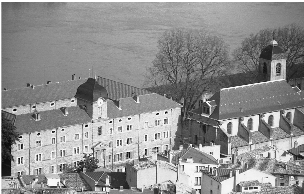
Bâtiment A et église, vue d'ensemble depuis le nord-ouest, v. 1976 (AP Plantin)
