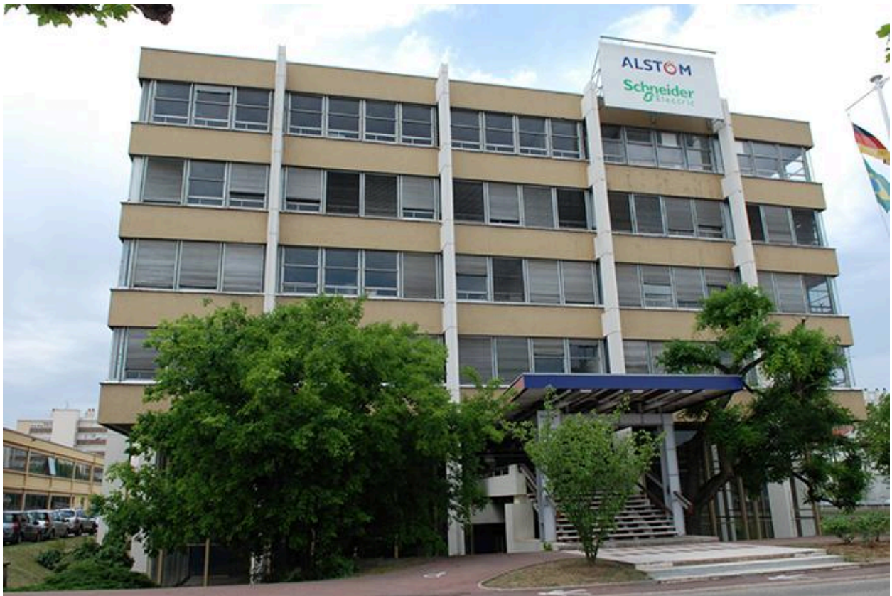
façade principale du bâtiment administratif
