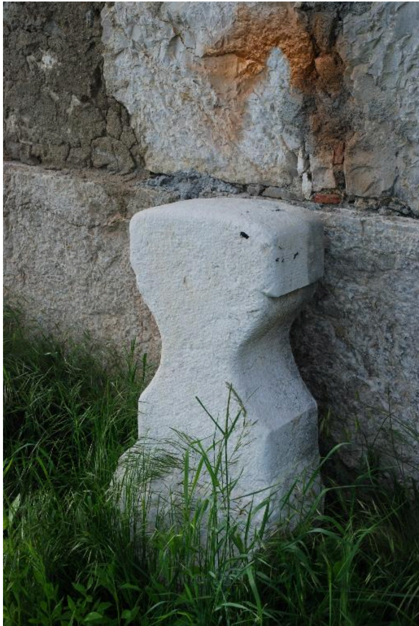
Détail d'une pierre déposée contre le bâtiment est (recto).
