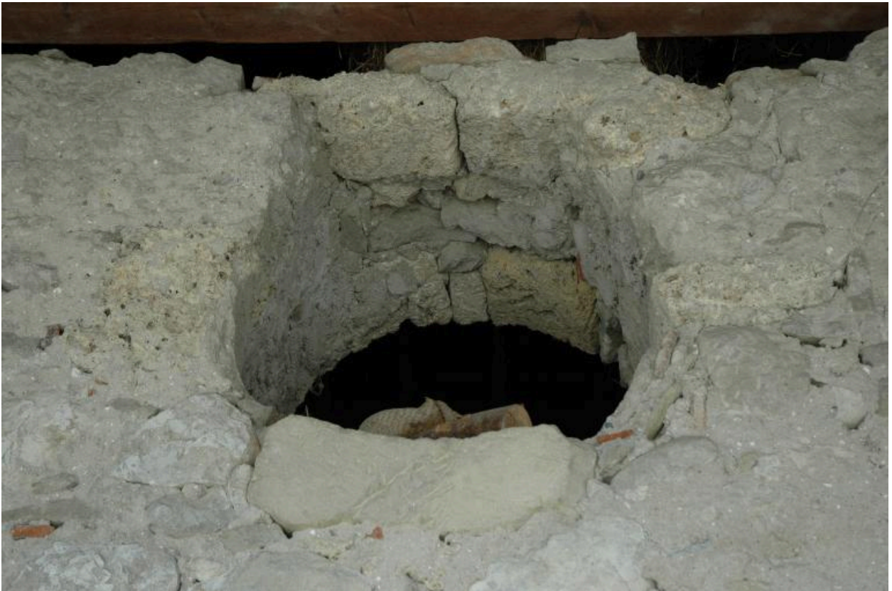
Détail de la façade des communs de la ferme.
