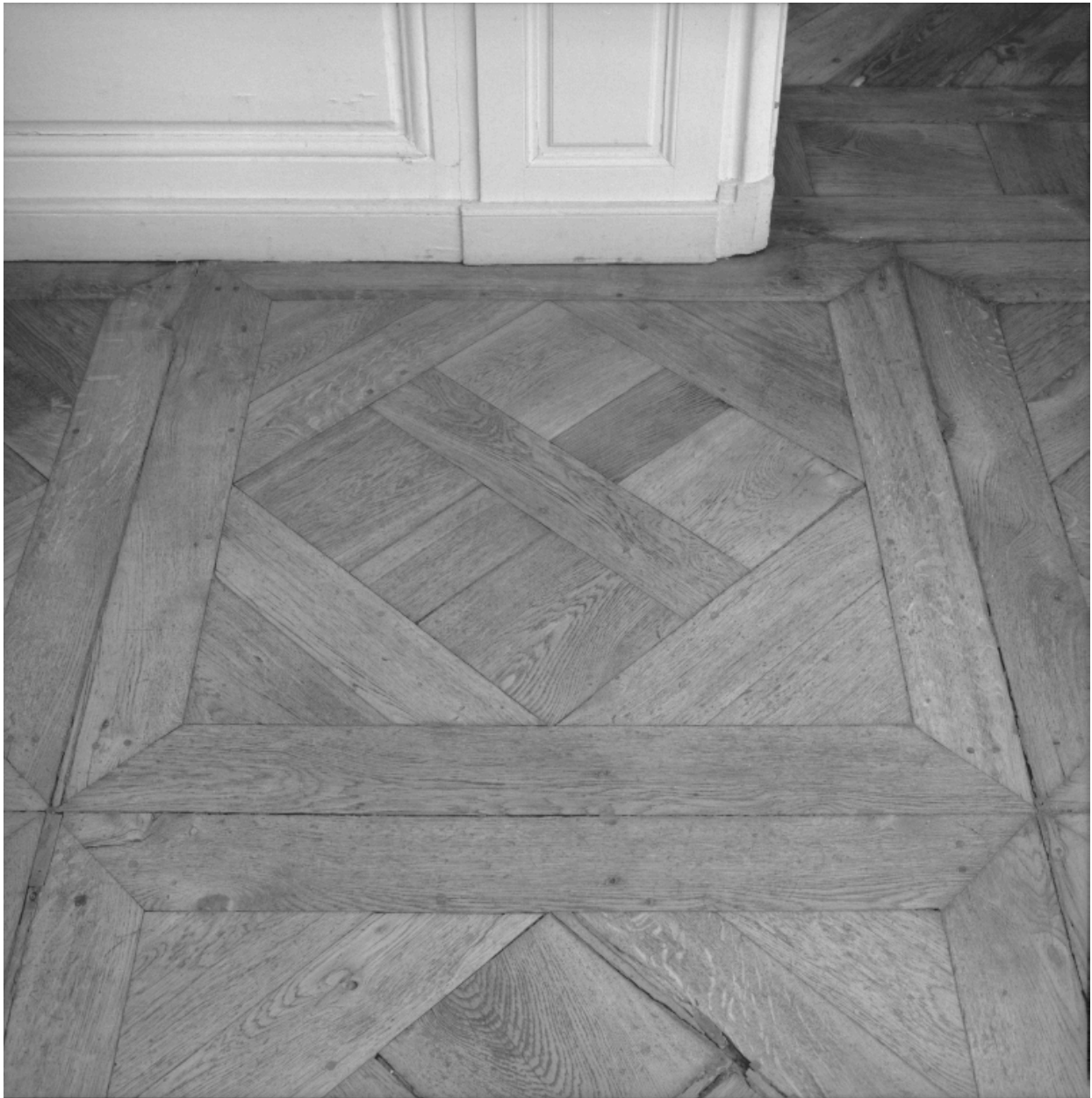
Détail d'un élément de parquet de la 2e chambre du rez-de-chaussée.
