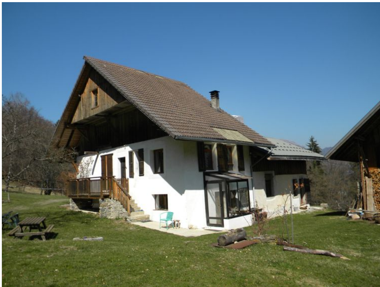
Alignement de façades d'anciennes fermes transformées.
